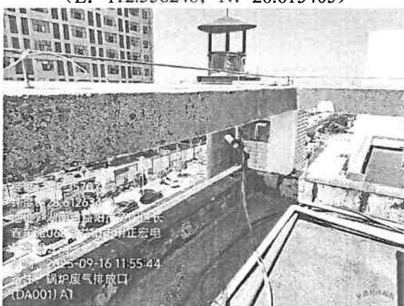
A 1 锅炉废气排放筒 (DA001) (E: 112.357022; N: 28.612634)
